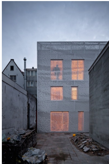
Рис. 3 Металлическое полотно фасада
