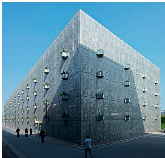
Рис. 10. Прозрачный стальной фасад: многоэтажная парковка, Альмере, Нидерланды
