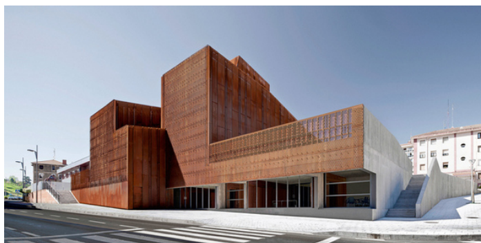
Рис. 6 Фасад полностью выполнен из кортеновской стали. Дом культуры ОКЕ, Ортуэлья, Испания
