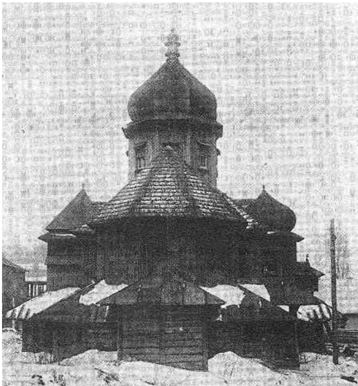
Рис. 3. Дерев'яна греко-католицька церква у Києві. Загальний вигляд. Фото С.І.Притикіна, березень 1935 р.
