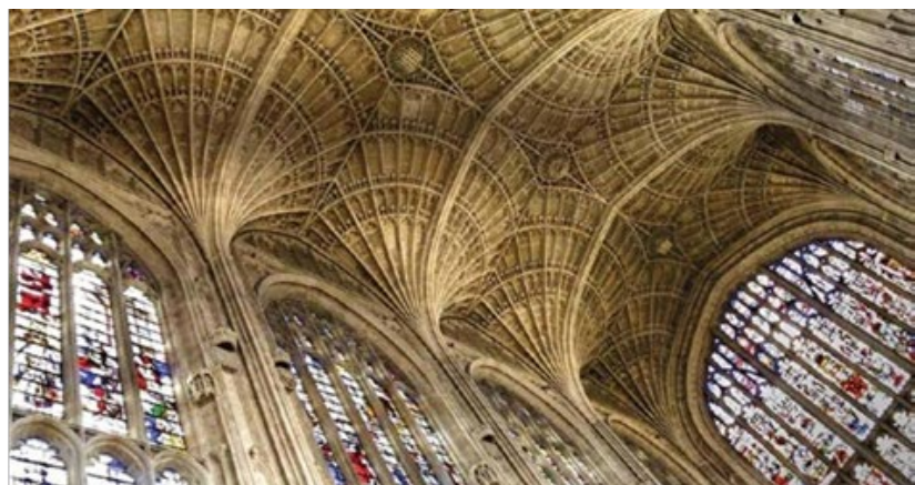
Рис. 6. Конструкція раковини та готичного віяльного склепіння, що наслідує форму
