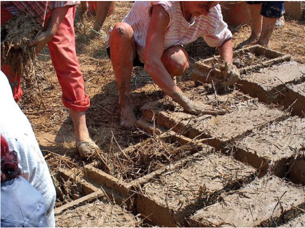
Рис. 2. Цегла ручної роботи з саману, для виготовлення якої використовуються ті ж компоненти, що й у гнізді ластівки
