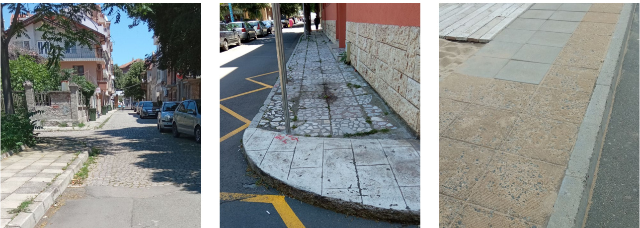
Рис. 4. Використання поруч застарілого пошкодженого покриття з різних матеріалів та узорів
