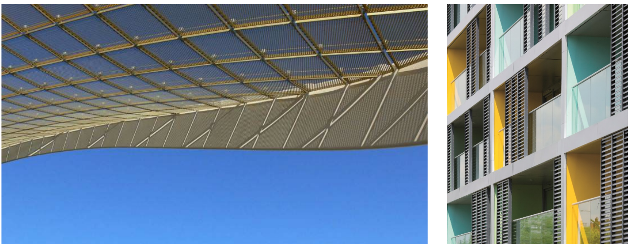
Рис. 1. Ліворуч – фасадні сітки, праворуч – фасадні ламелі
