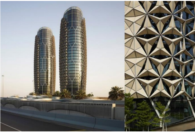
Рис. 7. Приклад «флексії архітектури», Штаб-квартира Інвест. Ради, Абу-Дабі, ОАЕ
