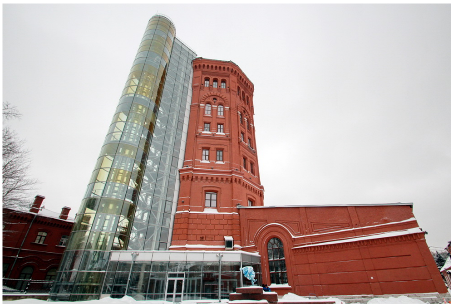
Рис. 4. Колишня водонапірна вежа в Санкт-Петербурзі, адаптована під музей (арх. Бюро «Інтерколумніум», 2003 р.) [6]
