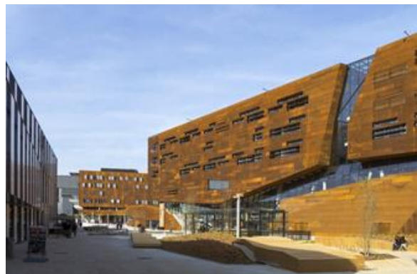
Рис. 7. Обладнання фасадів навчального центру кортенівською сталлю [2]
