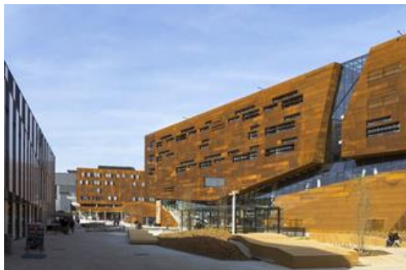
Рис. 7. Обладнання фасадів навчального центру кортенівською сталлю [2]
