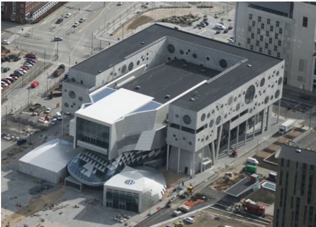
а) Загальний вигляд Будинку музики
